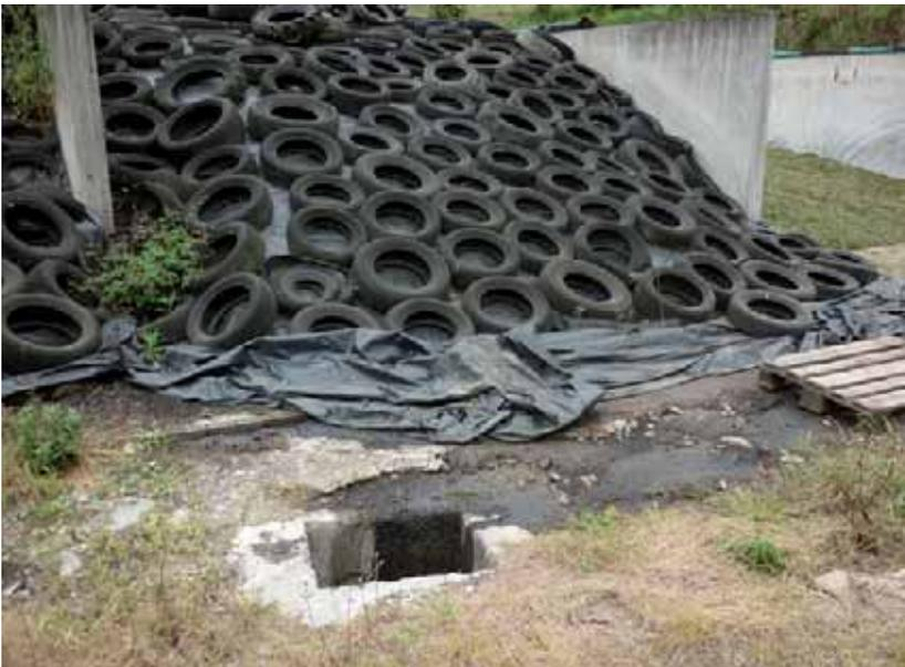
IX.1.- Fosa construida a pie de ensilado para captación de efluentes
